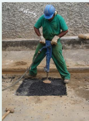
Asfalto a Frio (PMF)
